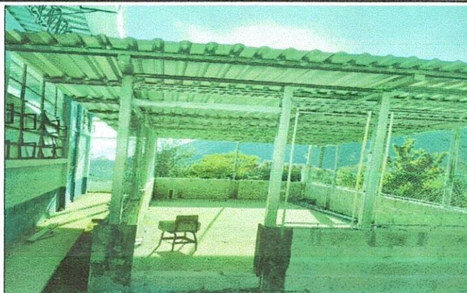
Foto 1: Terminación del cambio de techo de un aula.
